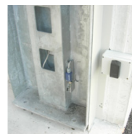
4. particolare inferiore del montante con funzione di guida e fotocellula / detail of the lower mounting with guide and photocell functions
